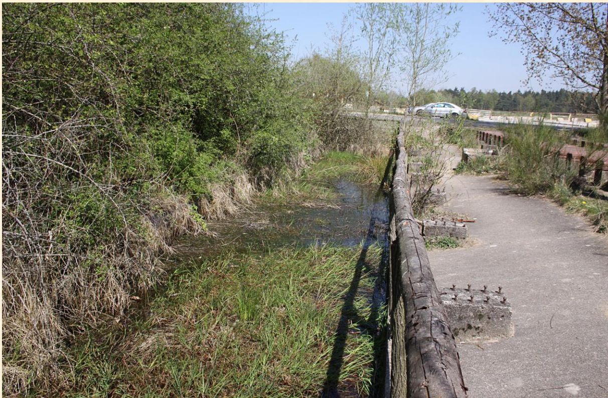
Abb. 1: Die Panzerwaschanlage an der Alten Kölner Straße, gegenüber dem mittlerweile zurückgebauten „Camp Altenrath“ der hier bis 2004 ansässigen belgischen Streitkräfte, aufgenommen Ende April 2015.
